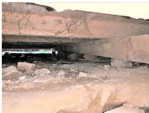
Foto 1 – Recalque da viga (2021).
